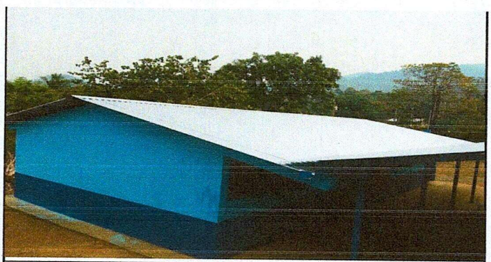
Foto 5: Entechado nuevo instalado en aula 1 y 2.
