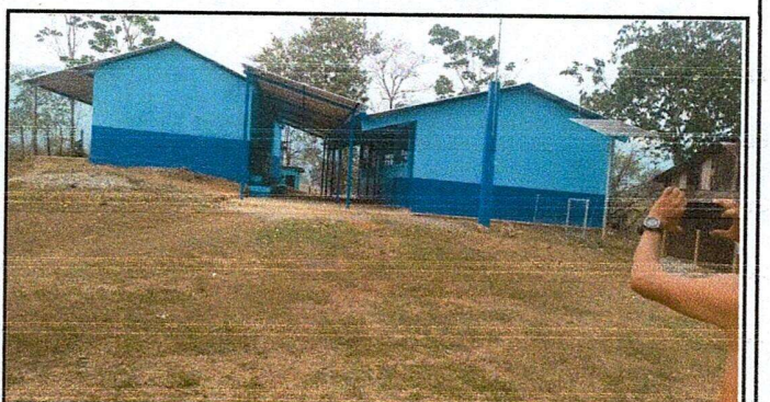
Foto 4: Aplicación de la pintura general.
