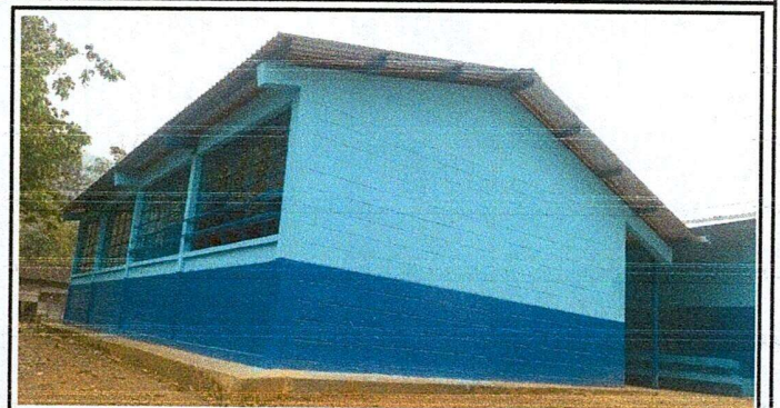
Foto 2: Mantenimiento de balcones en ventanas del aula 1 y 2.
