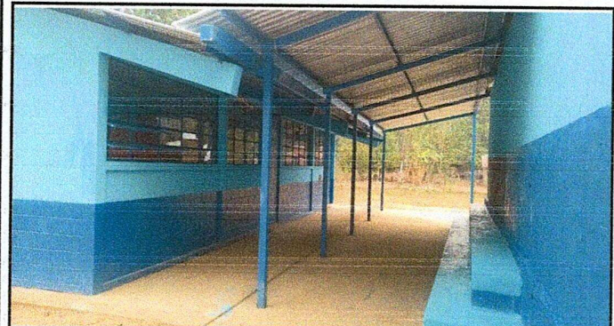
Foto 3: Aplicación de pintura en exterior.
