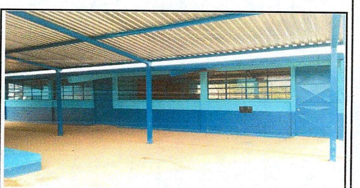
Foto 6: Entortado del patio finalizado.
